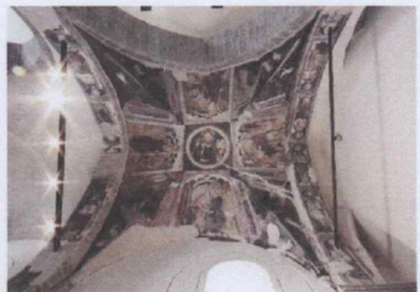
Dettaglio della terza campata di destra al piano terreno
